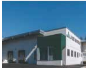
新炊飯工場全景
